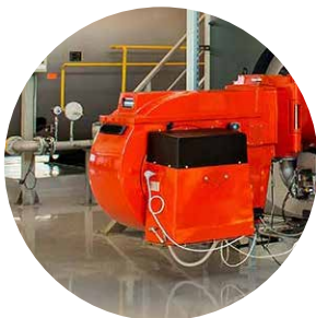
PULIZIE MACCHINARI E IMPIANTI INDUSTRIALI
